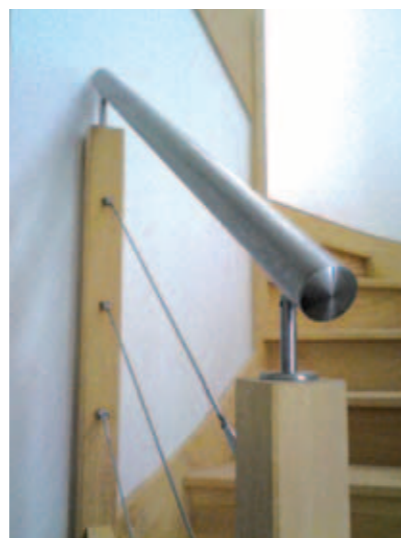
← Ri-3 : Détail d'une main courante inox.
