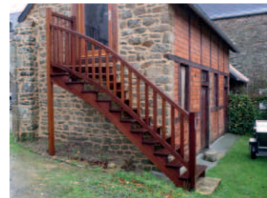
Pa-5 → Escaliers 1/4 tournant haut en iroko avec rampe extérieure bombée sur crémaillère.
