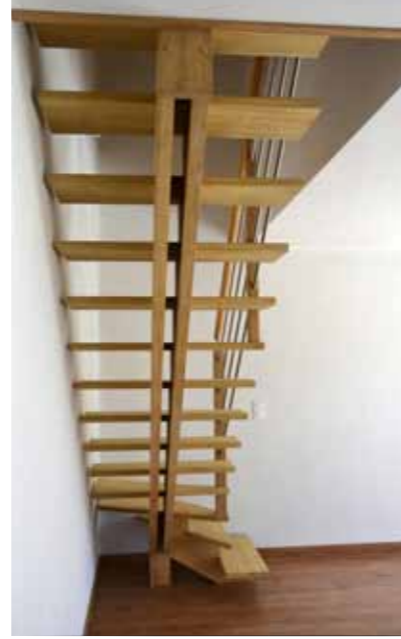
Eq-2 → Escalier 1/4 tournant bas en bois exotique jaune double crémaillères resserrées, main courante ronde.
