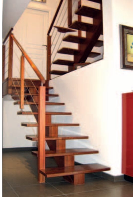
At-2 → Escalier droit à deux volées en bois exotique rouge, marche de départ S1, remplissage des rampes par des câbles inox, main courante ronde et poteau T6.
