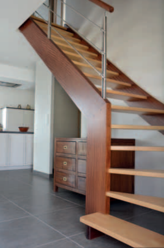
← Mf-1 : Escalier 1/4 tournant bas, Sans contremarches limon continu en bois exotique rouge, marches en frêne, poteaux rond inox.
