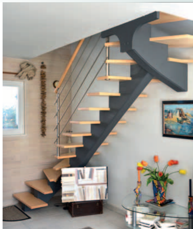
↗ → At-3 : Escalier 2/4 tournant sur limon central laqué ral 7016, rampe à poteaux ronds inox. Marches en frêne blanc avec fixations invisibles.
