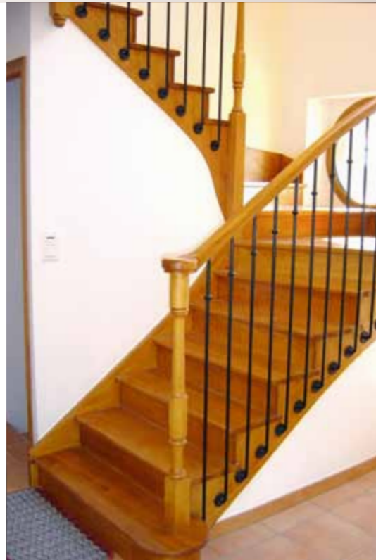
St-3 → Escalier 2/4 tournant sur crémaillère à l'anglaise avec contremarches en bois exotique jaune rampe à balustres métalliques thermolaquées avec petite bague F2 et rosace en partie basse. Départ sur volute T7 marche de départ S3.
