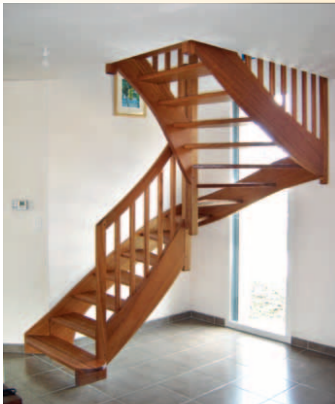
➤ ➔ Ep-4 : Escalier 2/4 tournant en bois exotique sapelli, marche de départ S3, poteau de départ T3, sans contremarches, remplissage des rampes par balustres bois, rampes bombées.
