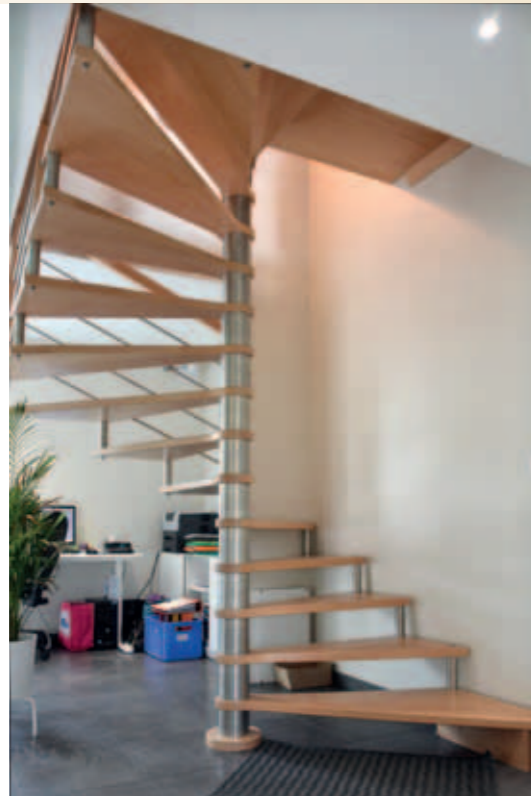
Na-3 → Escalier hélicoïdal de type kit carré en hêtre étuvé, structure sur entretoise extérieure en inox, fût central en inox, remplissage des rampes par 4 lisses inox.
