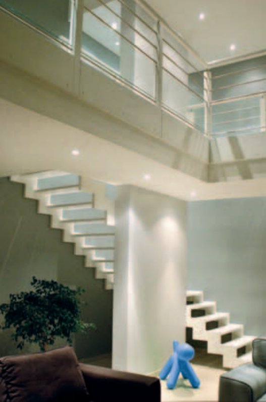
← De-1 Escalier 1/4 tournant milieu sans contremarches, limons travaillés en découpés dessus dessous, laquage blanc.
