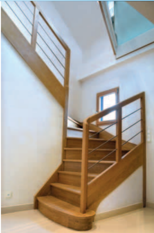
Ho-3 → ↓ Escalier 2/4 tournant en chêne, avec marche de départ galbée S7, poteau de départ T4, poteau T3, avec contremarches, remplissage des rampes par lisses inox vue sur passerelle vitrée.
