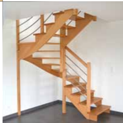
Ho-5 → Escalier 2/4 tournant en hêtre, sur crémaillère à « l'anglaise » marche de départ S1, poteau de départ T1, sans contremarches, remplissage des rampes par tubes inox.
