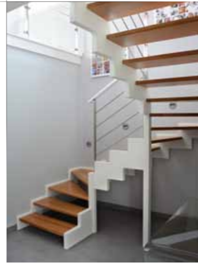
← Mf-2 : Escalier 2/4 tournant, Sans contremarches, limon design laqué blanc, marches en chêne, poteaux plats inox.
