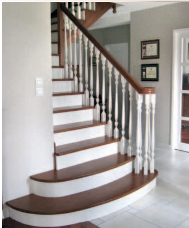
➤ → Tr-3 : Modèle d'escalier en sapelli 1/4 tournant milieu sur crémaillère découpée avec marches débordantes. Marche de départ double de type S8. Volute de départ formée d'un ensemble de balustres tournés et laqués dit "américain". Main courante MC1.
