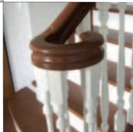
➤ → Tr-3 : Modèle d'escalier en sapelli 1/4 tournant milieu sur crémaillère découpée avec marches débordantes. Marche de départ double de type S8. Volute de départ formée d'un ensemble de balustres tournés et laqués dit "américain". Main courante MC1.
