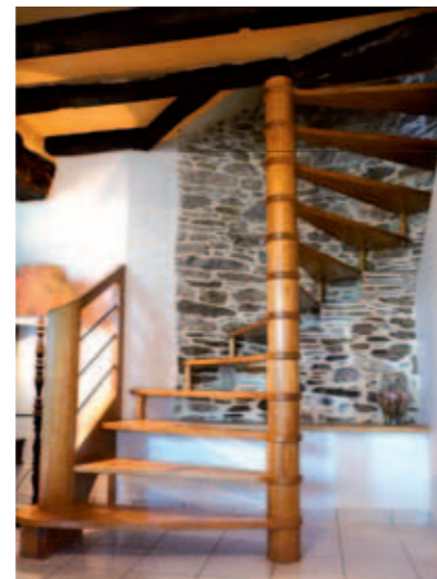
Na-4 → Escalier hélicoïdal sur fût central et entretoise extérieure en bois tourné, rampe de départ avec poteau T4 remplissage par trois lisses inox, en bois exotique jaune.
