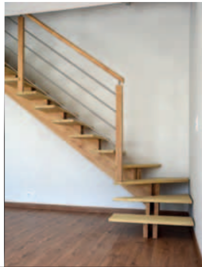
← Eq-3 : Escalier en en bois exotique jaune brut de ponçage non vernis.
