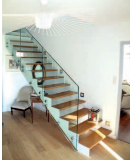
Ma-2 → Escalier à limon métallique gamme design en découpe dessus, rampe vitrée.
