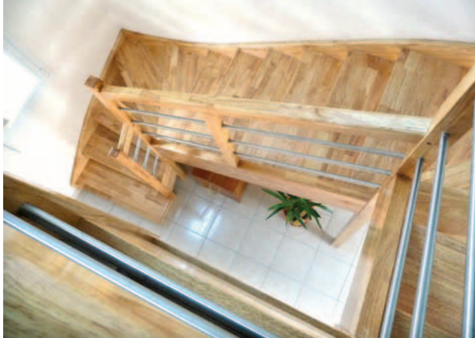
Fo-1 → Escalier 2/4 tournant sans contremarches rampe de départ T1.
