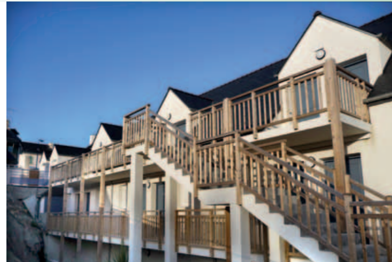
← Pa-3 Habillage de toute la façade d'un bâtiment. Rampes sur escaliers béton et garde-corps de coursive en pin traité.
