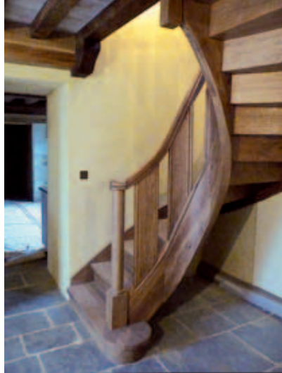
➤ Tr-1 : Réalisation historique respectant les procédés de fabrication de l'époque. Escalier en chêne 2/4 tournant sur limon débillardé. Poteau de départ et balustres reproduits d'après un modèle fourni.
