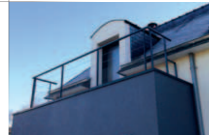
↓ Pa-8 Garde-corps métallique thermolaqué avec câbles et soubassement vitrage 44/2 clair sur pinces.
