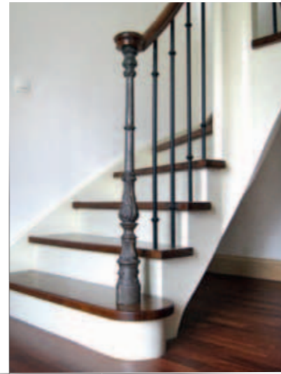
← St-2 Détail du poteau de départ en fonte. (voir configuration escalier ci-dessous)
