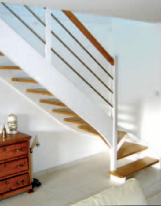
← Ho-1 : Escalier 1/4 tournant bas en bois exotique jaune pour les marches et main courante, limons laqués blanc, sans contremarches.
