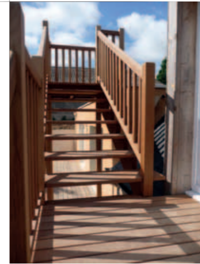
← Pa-2 Vue sur un escalier droit partant d'un palier d'arrivée d'un autre escalier.
