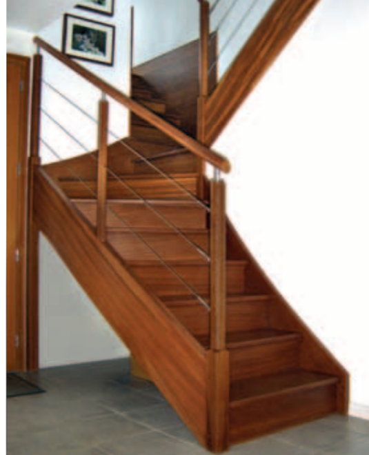
Ri-2 ➔ Escalier 2/4 tournant sur limon en bois exotique rouge, avec contremarches, tête de poteau T6 sur poteau rond tourné, avec contremarches, remplissage des rampes en câble inox.
