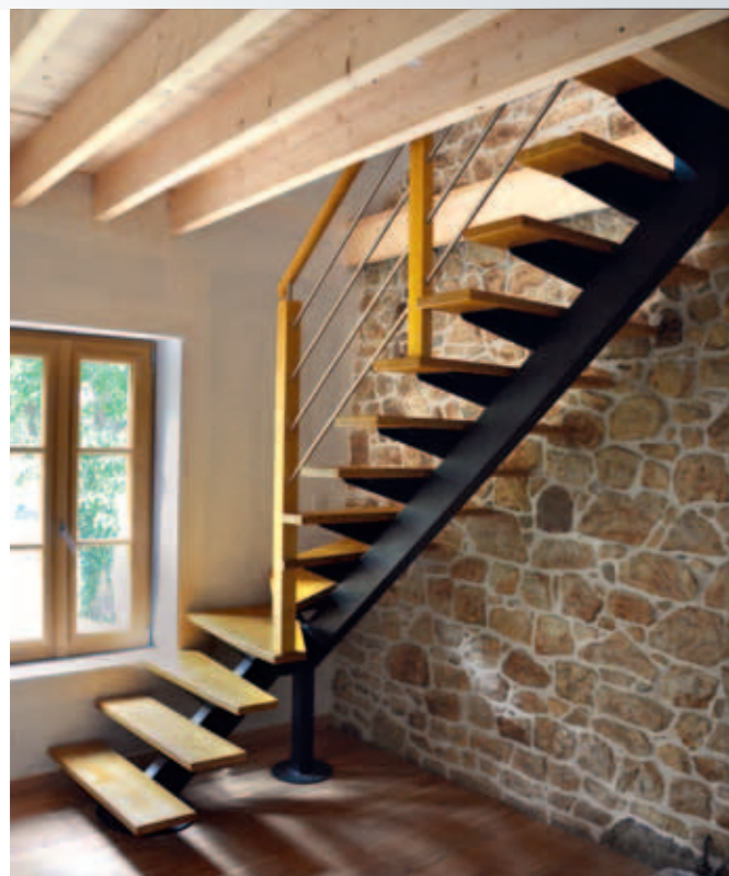
↗ Ma-4 : Escalier sur limon central métallique thermolaqué, marches en bois exotique jaune.
