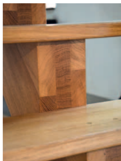
← At-4 : Détail sur limon central sans plaque, fixation des marches apparentes et bouchons de finition.
